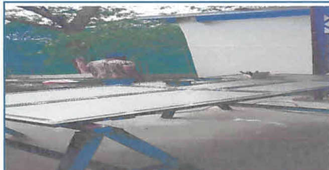
Foto 6: fabricación de puerta de metal
