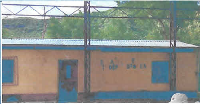
Foto 1: Instalación de estructura y techo
