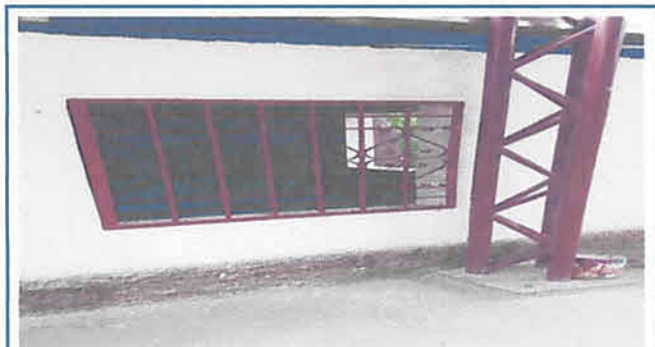
Foto 4: Colocación de balcones
